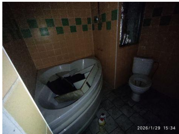
byt. jednotka č.4- koupelna s WC
