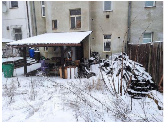
pergola na pozemku čís. parcely 2822 navazující na BD č.p.923
