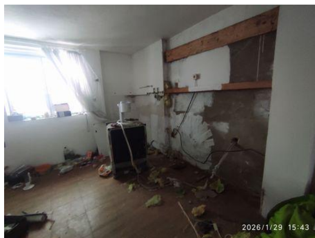
byt. jednotka č.5- kuchyňský kout
