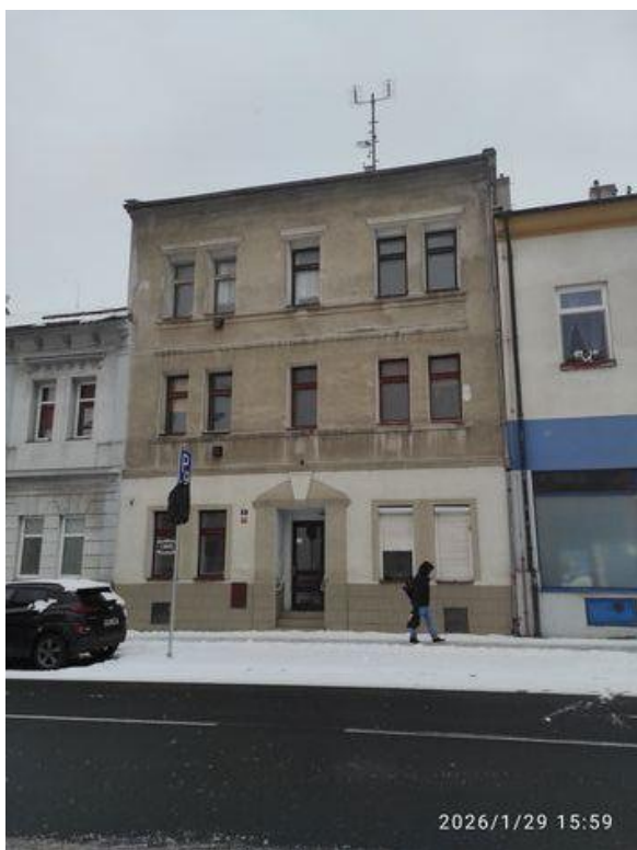
čelní pohled na budovu č.p.923 z ul. Školní
