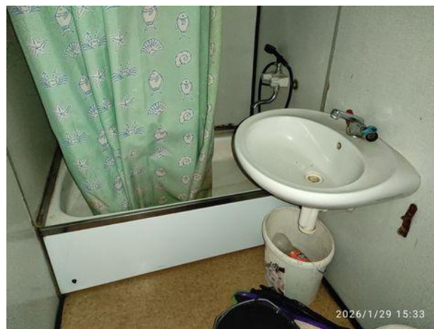
byt. jednotka č.3- koupelna v přefa byt. jádře
