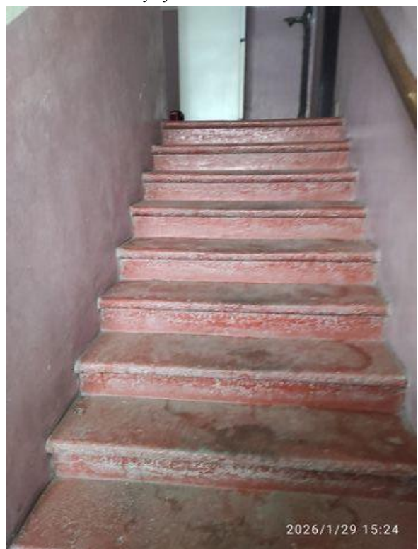
schodiště do 2.nadzemního podlaží
