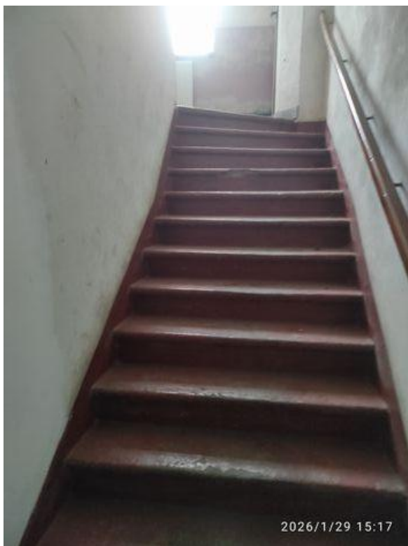
schodiště do 2.nadzemního podlaží
