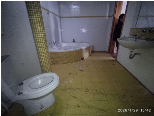
byt. jednotka č.5- koupelna s WC
