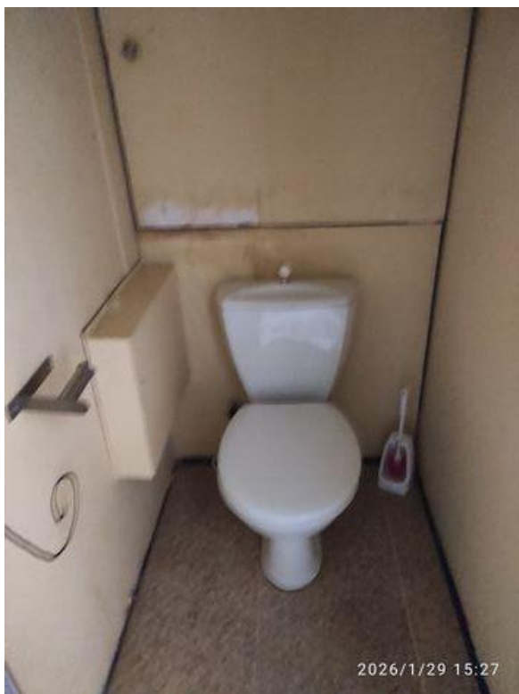
byt. jednotka č.1-WC v přefa byt. jádře
