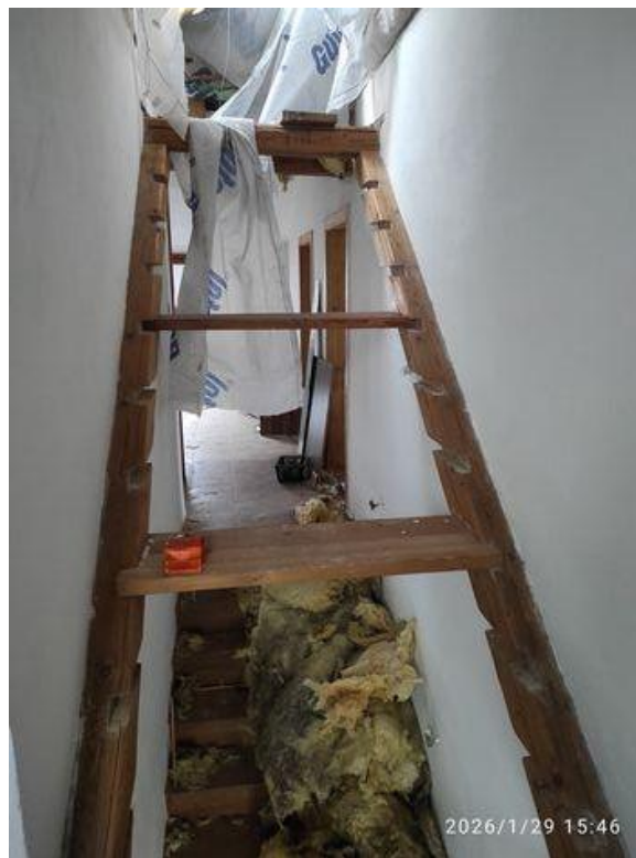
demontované schodiště pro přístup na střešní terasu
