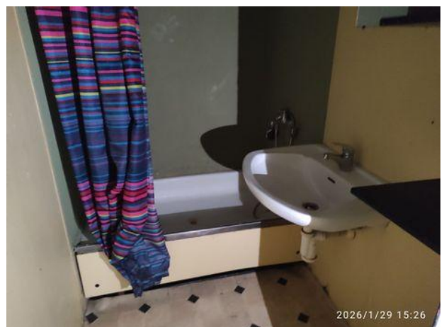
byt. jednotka č.1- koupelna v prefa byt. jádře
