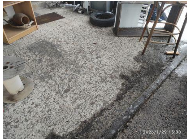
zpevněná plocha z monolitického betonu na pozemku čís. parcely 2822
