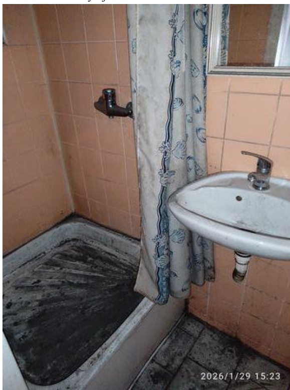
nebyt. jednotka č.2-soc. zařízení
