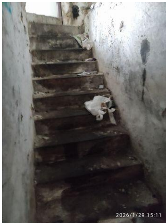
schodiště v úrovni 1.podzemního podlaží
