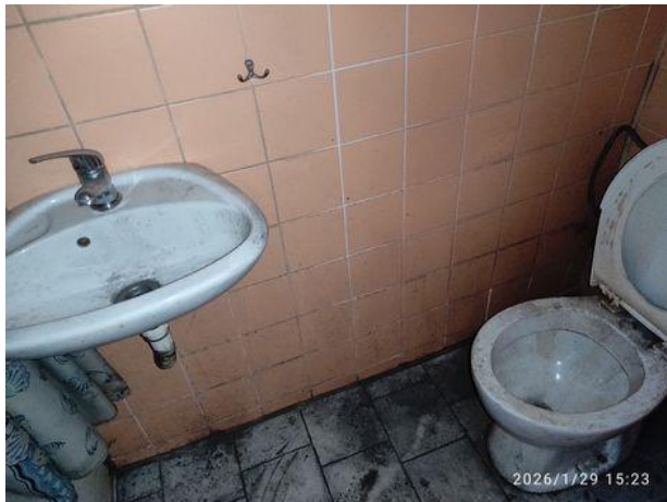
nebyt. jednotka č.2-soc. zařízení
